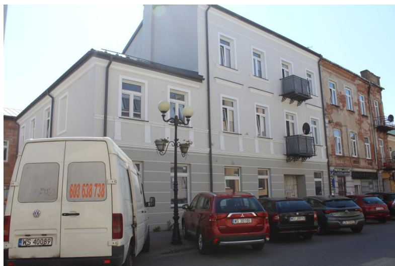
Fotografia: Kamienice przy ulicy Asza
