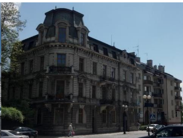
Fotografia: Kamienica przy ul. Floriańskiej
