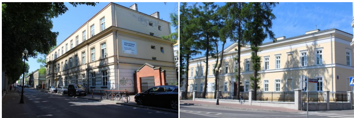
Fotografie: Budynek IV LO im. Stanisława Żółkiewskiego i Szkoły Podstawowej nr 1 im. KEN przy ul. Konarskiego.
