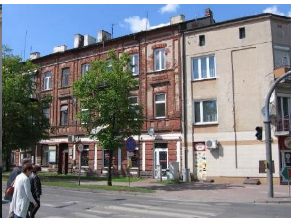
Fotografia: Budynki przy ul. 3 Maja
